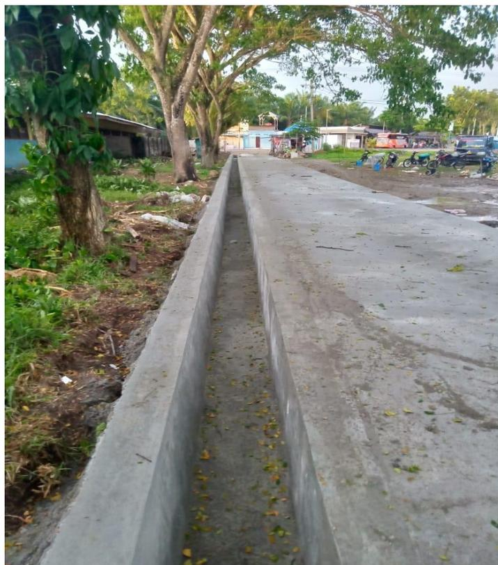
Gambar 3.10. Pembuatan Rabat Beton dan Drainase Sisi Lapangan Bola Sei Bejangkar Kec. Sei Balai
